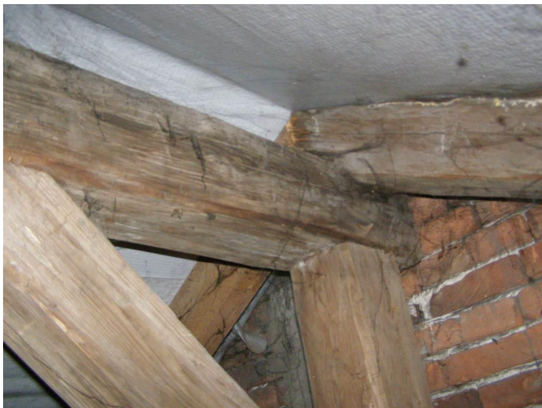
Fot.13. Sala senacka UEK – Więźba dachowa. Oparcie krokwi na płatwi kalenicowej.
