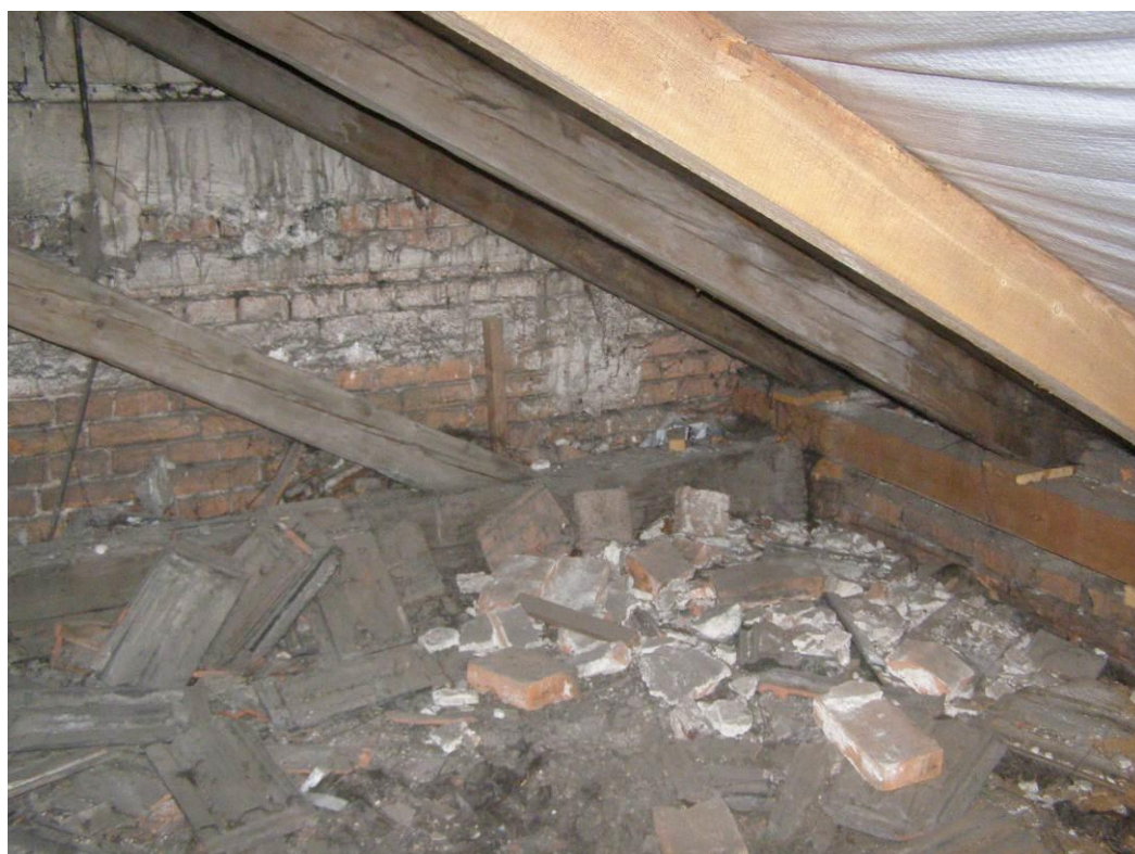
Fot.14. Sala senacka UEK – Więźba dachowa. Oparcie krokwi na murłacie. Widoczny gruz(cegły i dachówki) zalegający na stropie drewnianym
