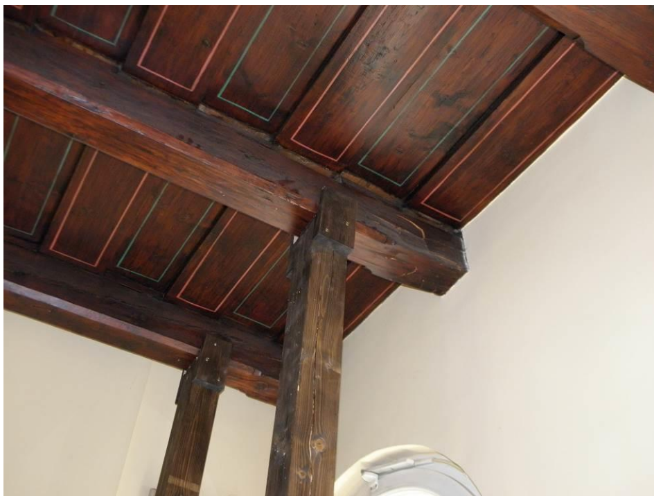
Fot.5. Sala senacka UEK – Widok uszkodzonych belek stropowych ze słupami podpierającymi
