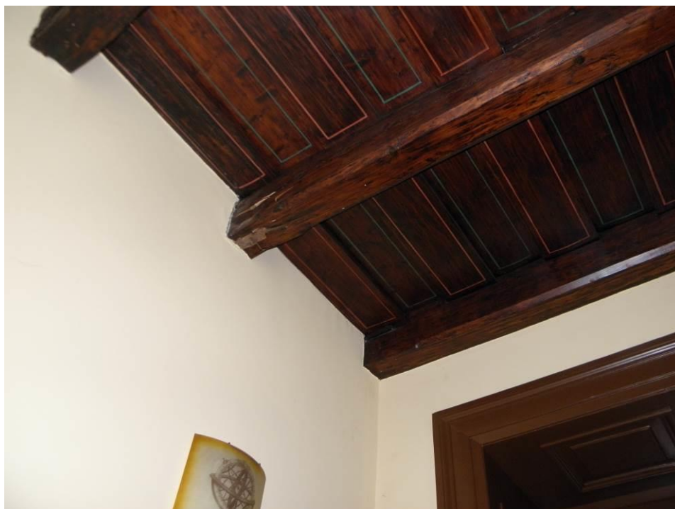
Fot.3. Sala senacka UEK – Widok belek stropowych z widocznymi uszkodzeniami w strefie oparcia
