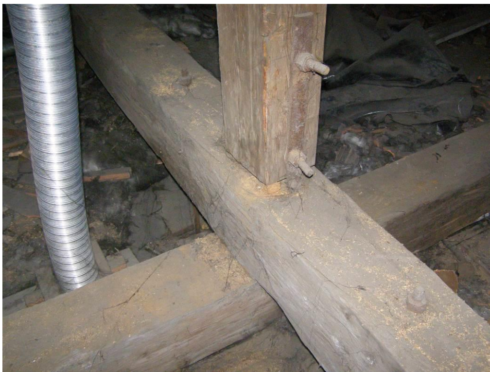
Fot.11. Sala senacka UEK – Więźba dachowa. Węzeł wieszaka, tramu poprzecznego i podłużnego.
