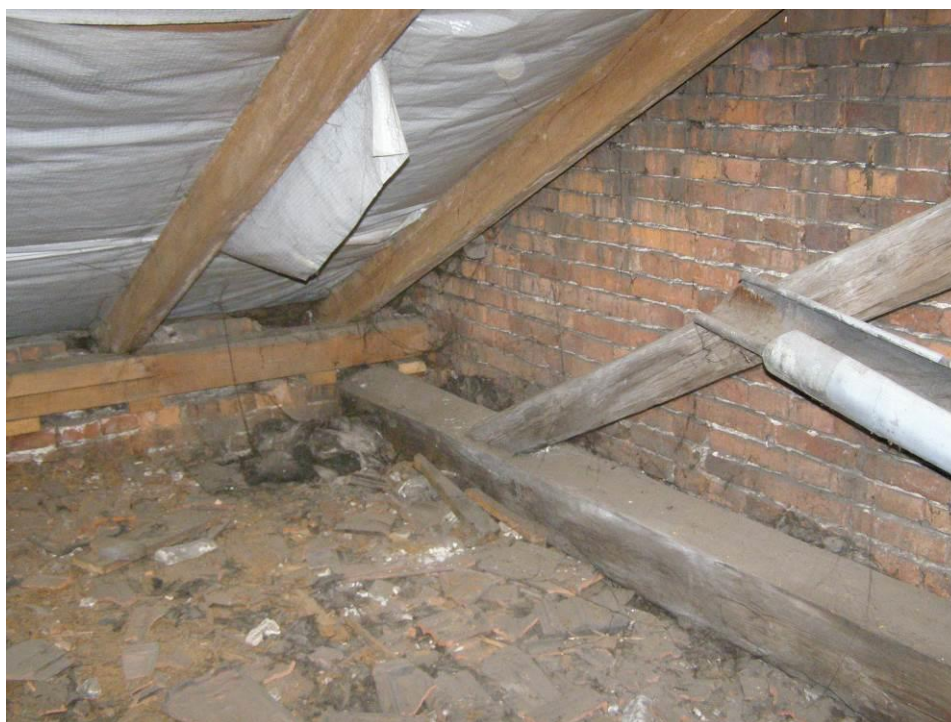
Fot.8. Sala senacka UEK – Więźba dachowa. Oparcie krokwi i tramów więzara W-1.
