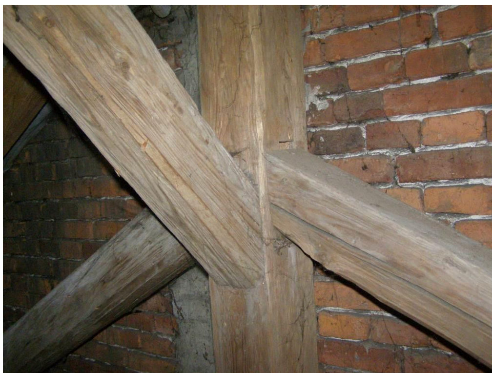
Fot.12. Sala senacka UEK – Więźba dachowa. Połączenie wieszaka więzara z zastrzałami i mieczem.
