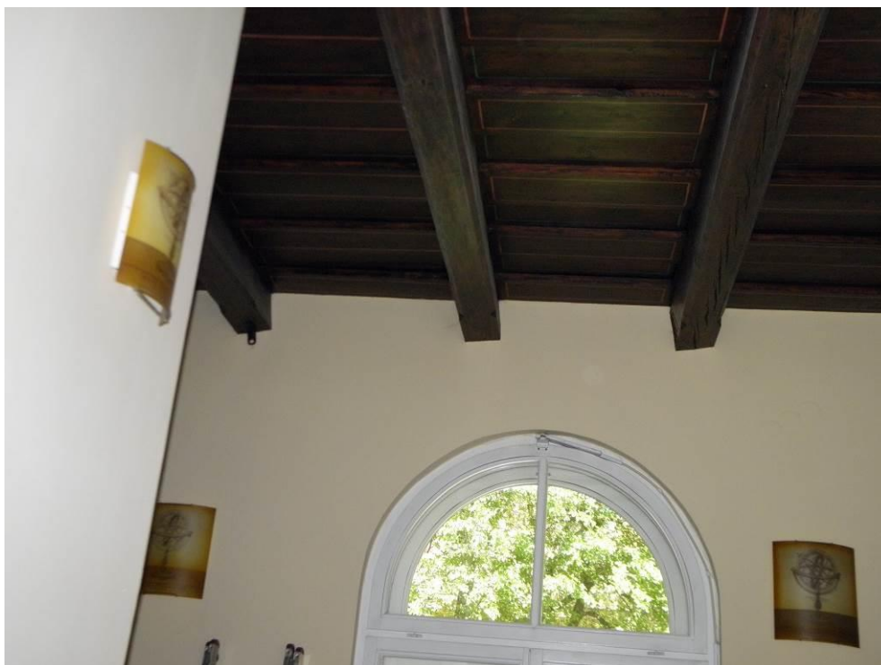
Fot.7. Sala senacka UEK – Widok stropu drewnianego. Widoczne deformacje skrętne belek.
