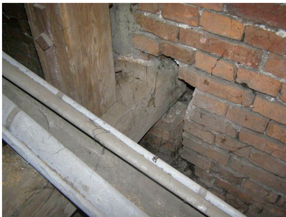
Fot.10. Sala senacka UEK – Więźba dachowa. Widok oparcia tramu podłużnego.
