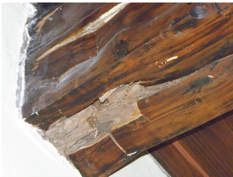
Fot.4. Sala senacka UEK – Widok zniszczonej belki stropowej w strefie oparcia
