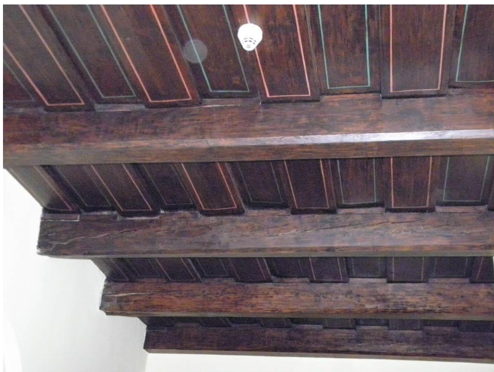
Fot.2. Sala senacka UEK – Widok stropu drewnianego. Widoczne spękania belek.
