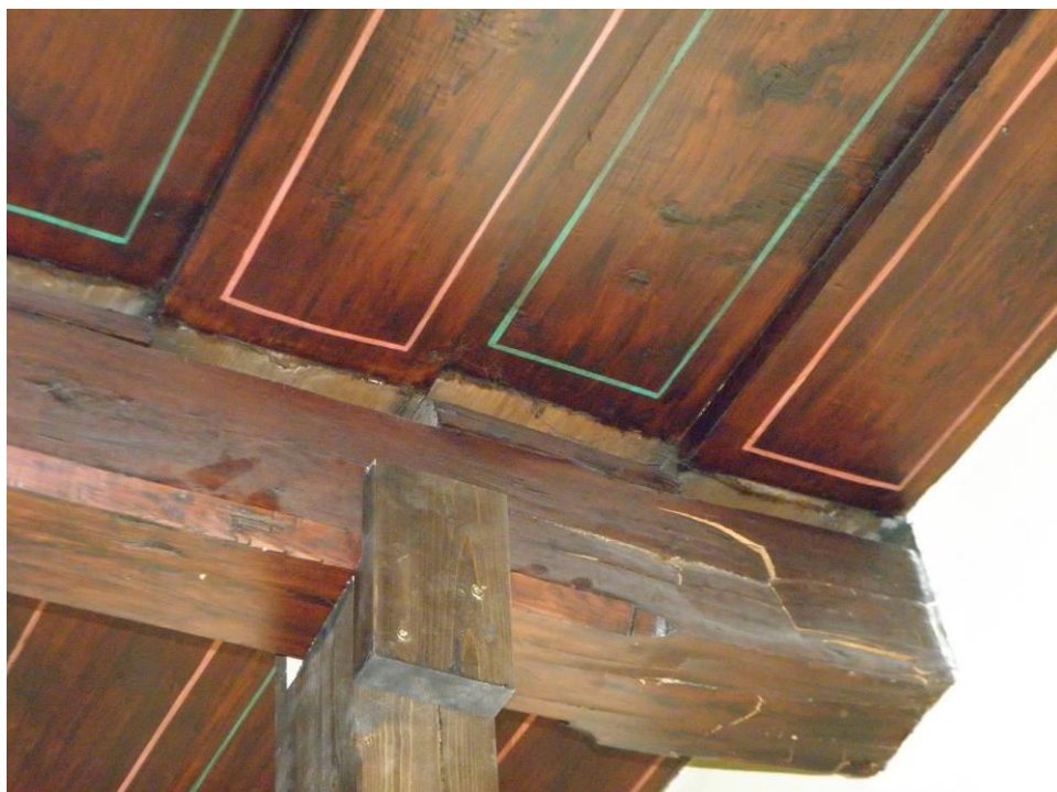
Fot.6. Sala senacka UEK – Widok podparcia uszkodzonej belki stropowej
