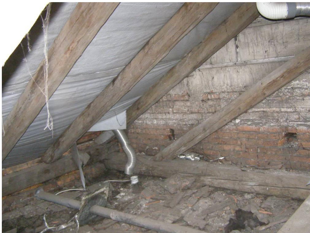
Fot.9. Sala senacka UEK – Więźba dachowa. Widok krokwi i więzara W-3.
